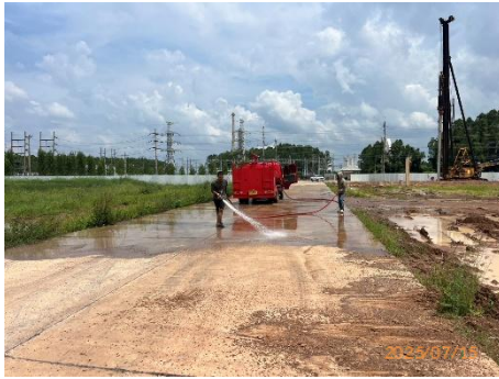
รูปที่ 2-1 การฉีดพรมน้ำเพื่อลดฝุ่น
